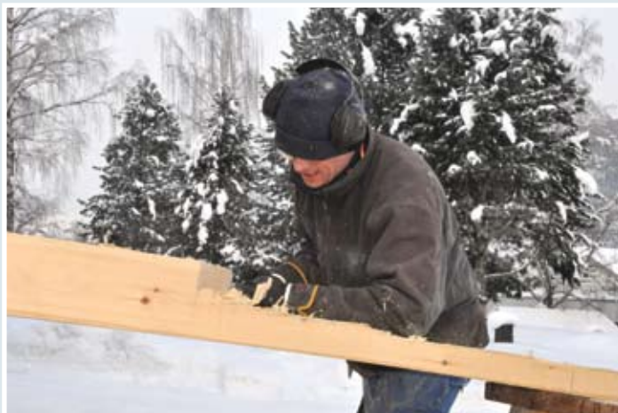
Franck Favris i ferd med å tilpasse nye bjelker for innsetting
