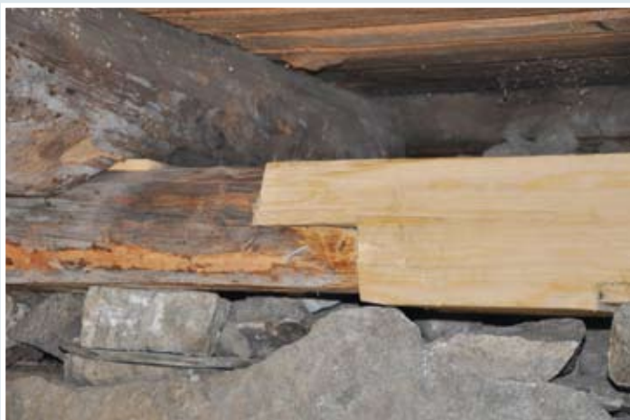
Det er tatt vare på så mye som mulig av det originale materialet, og spleiset på med nye stokker
